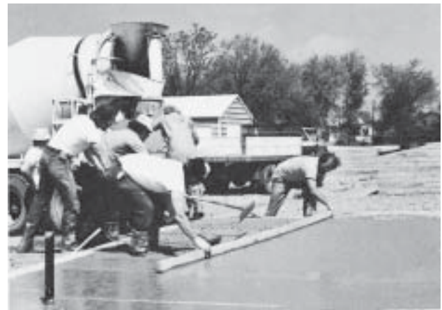
Acabado del concreto
